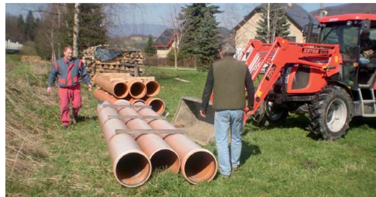
Vľavo stojaci Ján Tomáš riadi stavbu
