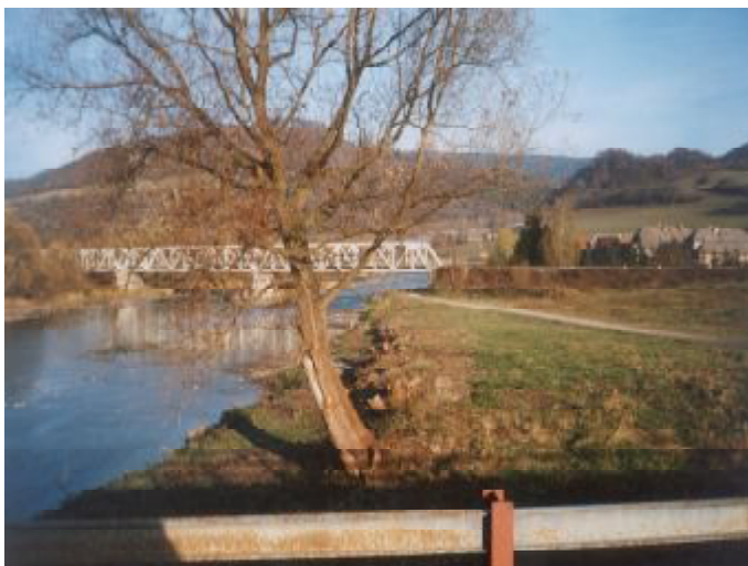
Pohľad na upravený priestor medzi mostami.
