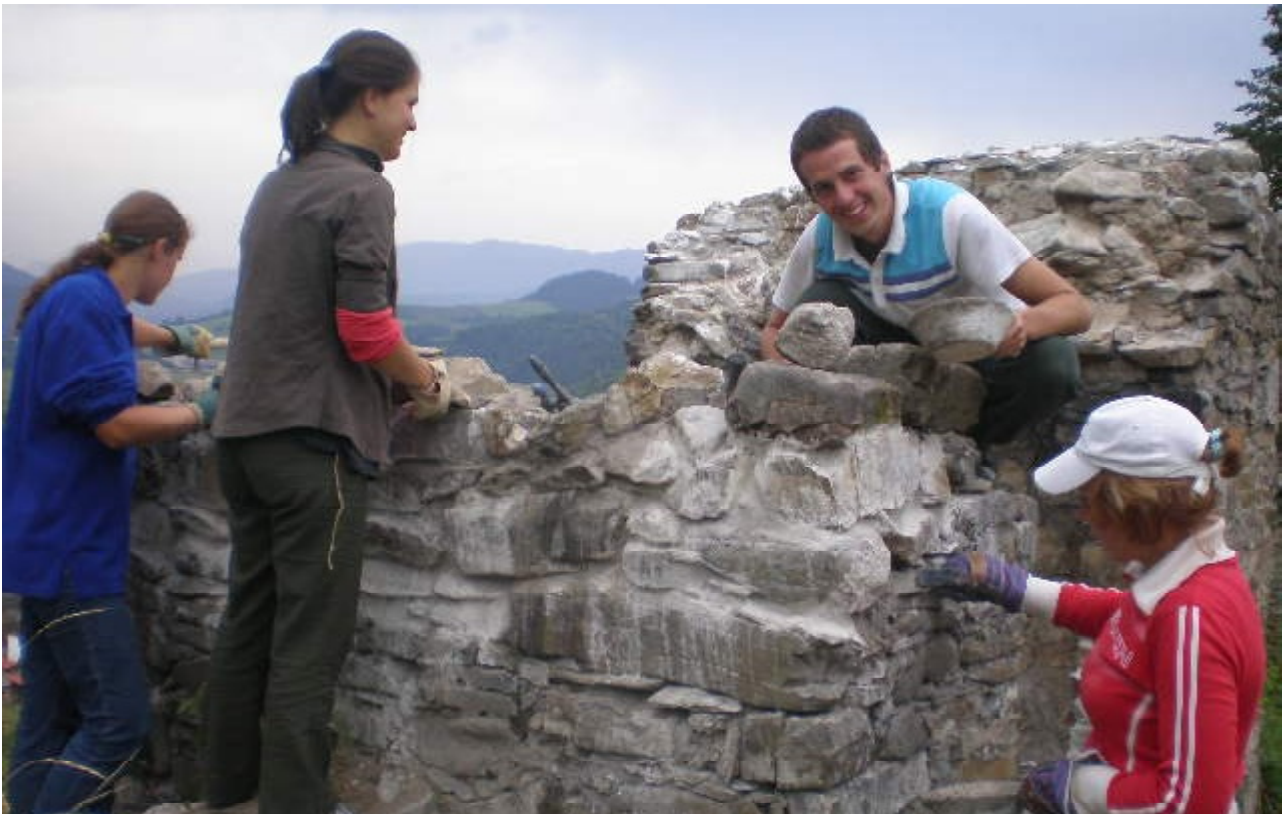
Pri spevňovaní obvodových múrov kostolíka
