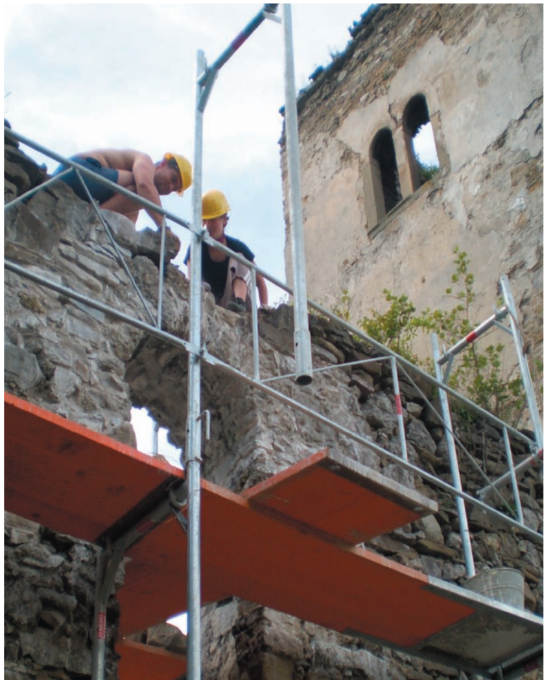
Spevňovanie obvodového múru zrúcaniny kostola
